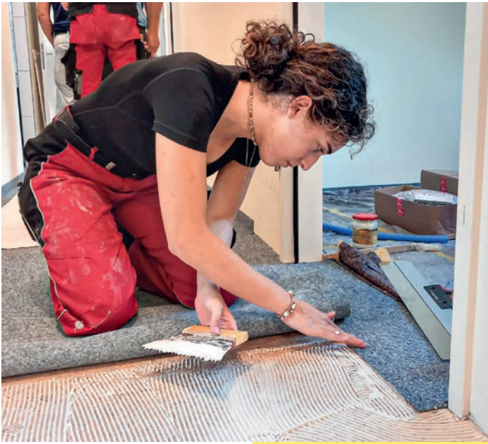
Oberstes Bild: Leann Gantenbein verlegt den Teppichboden. Mittleres Bild: Manuel Gort ist mit dem Aufbau der Aussentreppe beschäftigt.
